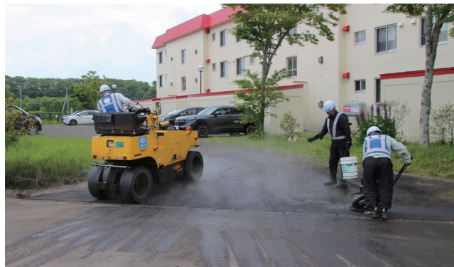
駐車場入口を整備する作業員
