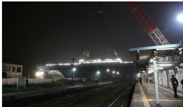
大型クレーンを使用して行われた夜間作業
