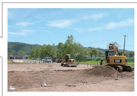
現在ドッグランを建設中です
