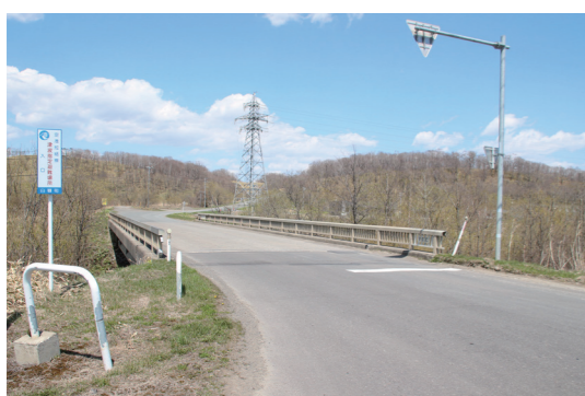
釧路空港へとつながる富留川3号橋
