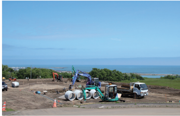
現在工事を行っている樹木葬墓所の整備箇所。海や街並みが一望できる場所です。
