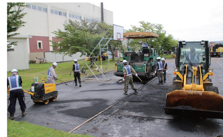
総合体育館駐車場の北側部分を大々的に補修していただきました
