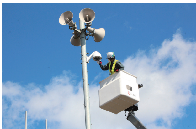
高所作業車を使ってカメラを清掃
