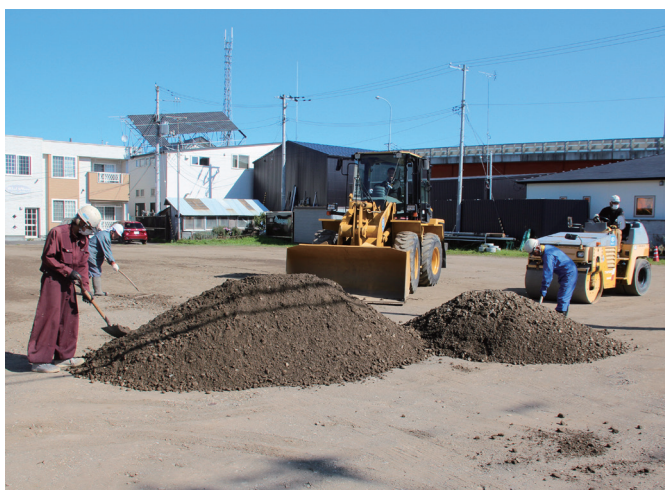
細かなところは手作業で整地
