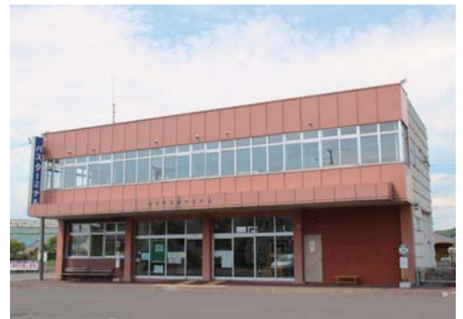
老朽化が著しい町営バスターミナル。まちの新たな拠点となる複合施設の整備に向け、検討を進めます。
