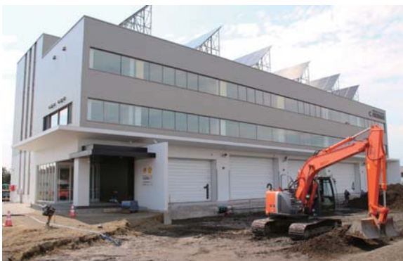
10月の供用開始に向けて、外構工事を行っている消防庁舎。
