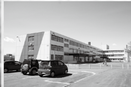
河川から近く、移転が望まれる白糠小学校
