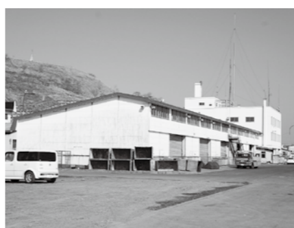
5億円の大規模改修となる荷さばき施設
