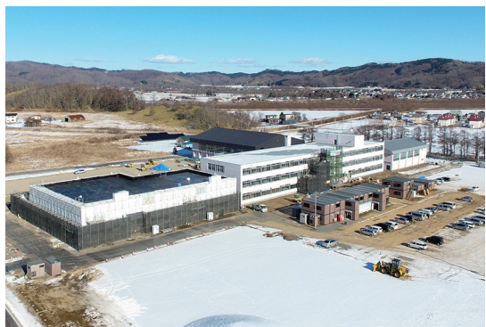
現在改修中の白糠学園。8月（2学期）に開校となります。
