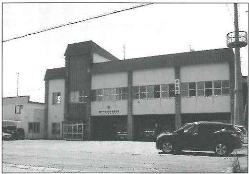
改築と職員の居住対策が問題の消防白糠支署
